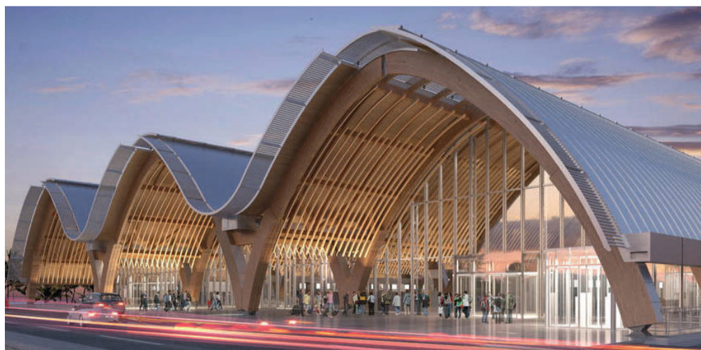
COMPLETAMENTE IN LEGNO LAMELLARE il terminal passeggeri dell'aeroporto internazionale di Mactan-Cebu
