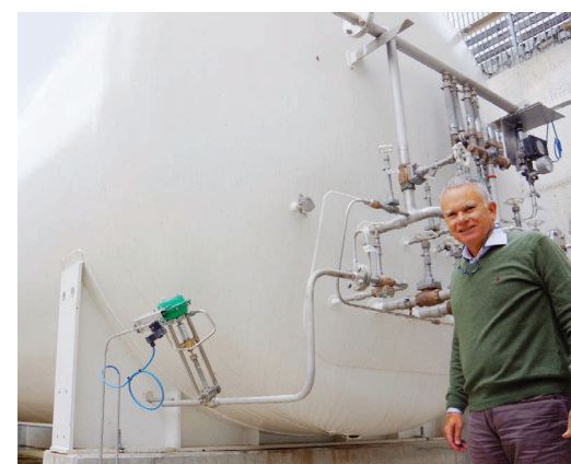
KURT ECCEL A FIANCO DEL NUOVO SERBATOIO GNL capacità di stoccaggio 100 m3
