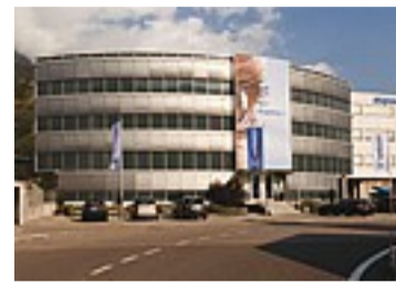
ALUPRESS SPA La sede centrale a Bressanone
