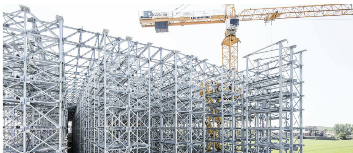
MAGAZZINO AUTOPORTANTE VERTICALE FIRMATO STAHLBAU PICHLER 2.400 tonnellate di strutture in acciaio
