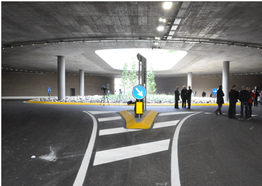
Auch ein unterirdischer Kreisverkehr gehört zum ersten Teilstück der Meraner Nordwest-Umfahrung.
