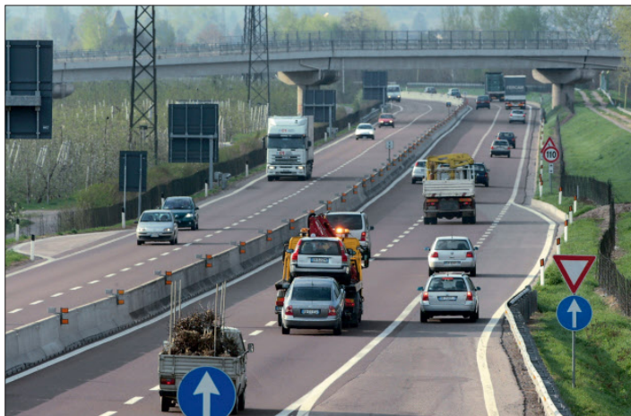
Beim Unterbau der Mebo kam fast nur Recyclingmaterial zum Einsatz.
