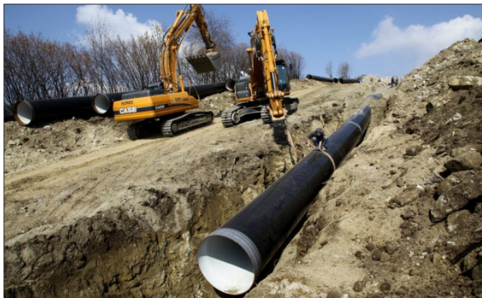
Die Wasserzuleitungen werden unterirdisch verlegt.
