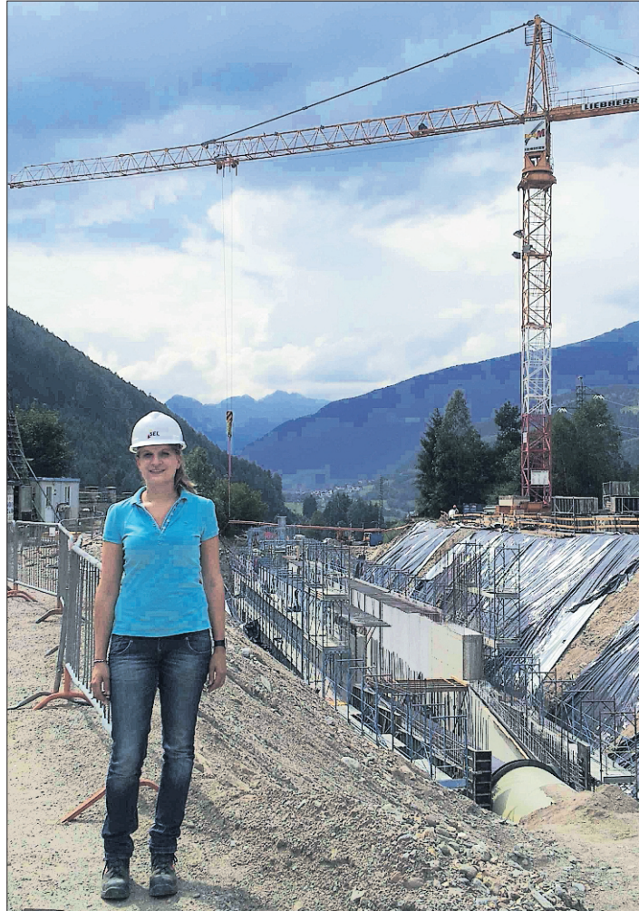
Besonders gerne ist Sabine Psaiar auf Baustellen unterwegs.
