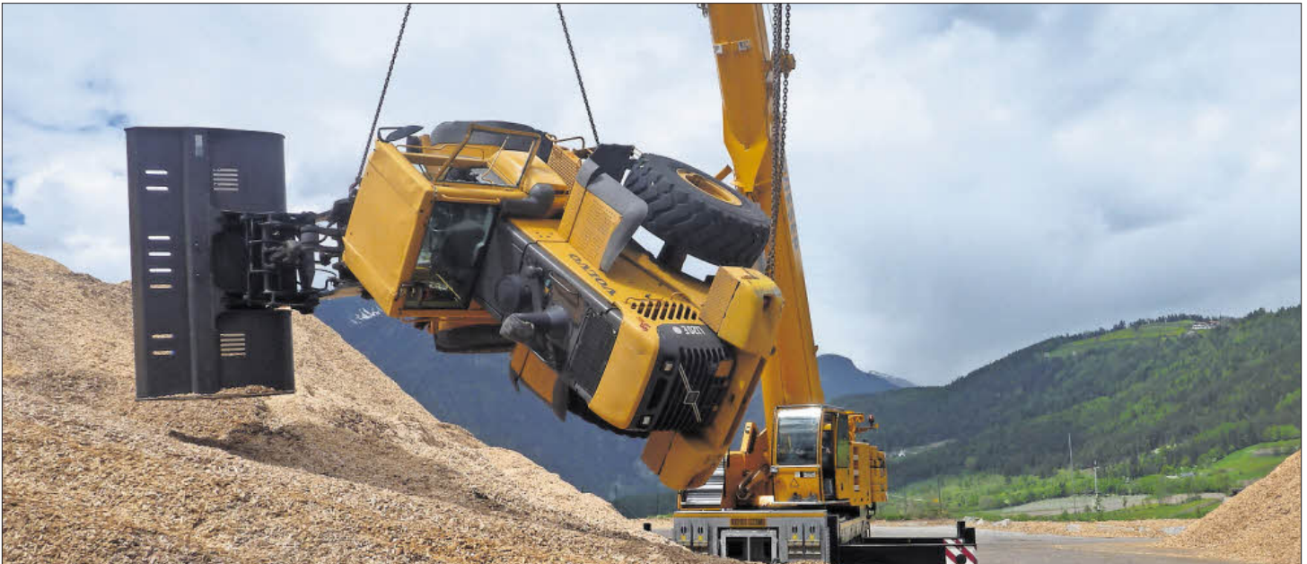
Mit Leichtigkeit hebt der 10 Tonnen schwere und 540 PS starke Kranwagen einen umgekippten Radlader auf und bringt ihn wieder in die richtige Position. Wieser OHG
